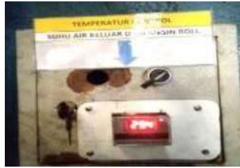
Gambar 5. Penambahan alat kontrol suhu
