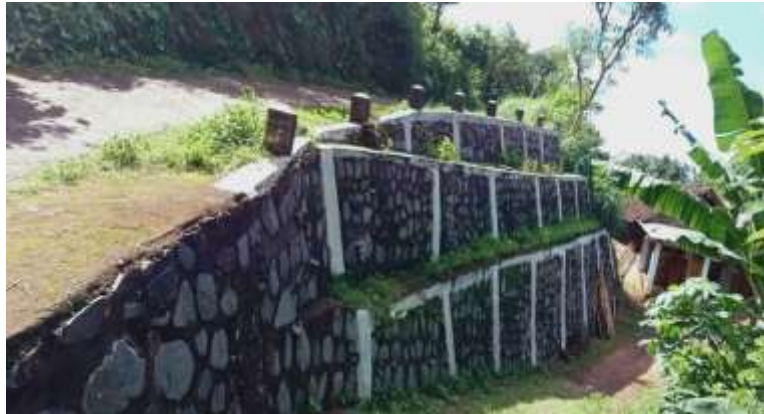
Gambar 8. Pembangunan Tembok Penahan Tanah
