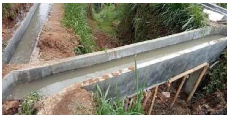
Gambar 9. Pembangunan Saluran Irigasi
