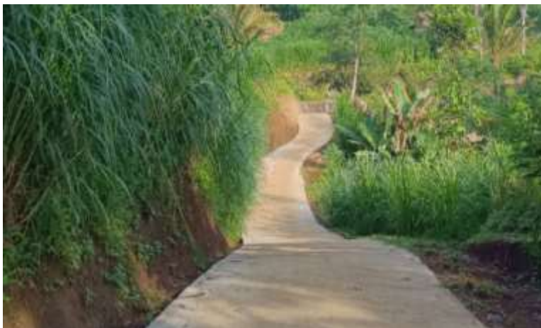
Gambar 10. Pembangunan Jalan Rabat
