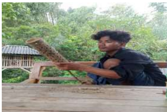
Gambar 2. Memasukkan kabel pada bamboo
