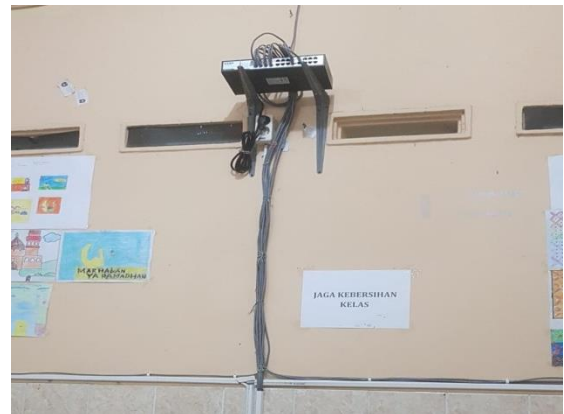
Gambar 4. Hasil Pemasangan Switch
