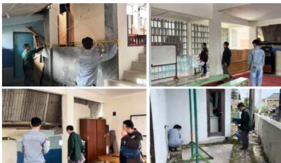
Gambar 5. Kegiatan pengecekan dimensi dan kesesuaian kondisi aktual dengan gambar desain
