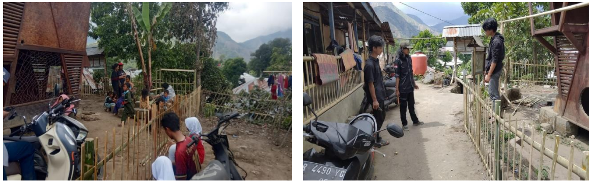
Gambar 5: Proses Renovasi Rumah Baca
