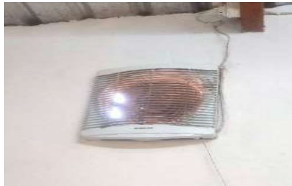
Gambar 9. Pemasangan exhaust pada dapur UMKM Sumber: Dokumentasi
