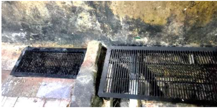
Gambar 8. Pemasangan filter pada saluran pembuangan Sumber: Dokumentasi
