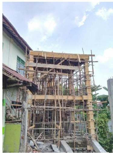
Gambar 3. Pembangunan Tandon Air
